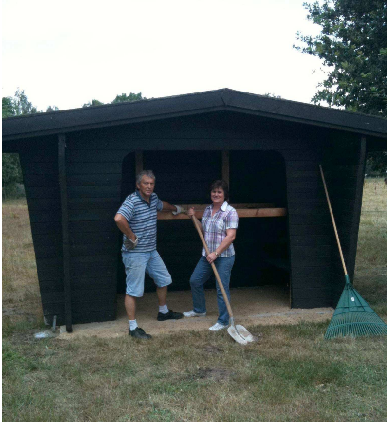
Bau der Schutzhütte 2010 in Eigenleistung!
