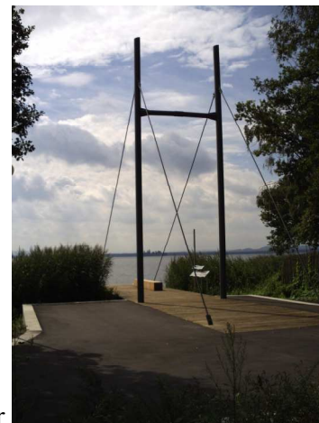
Sehbrücke Mardorf: Sommer
